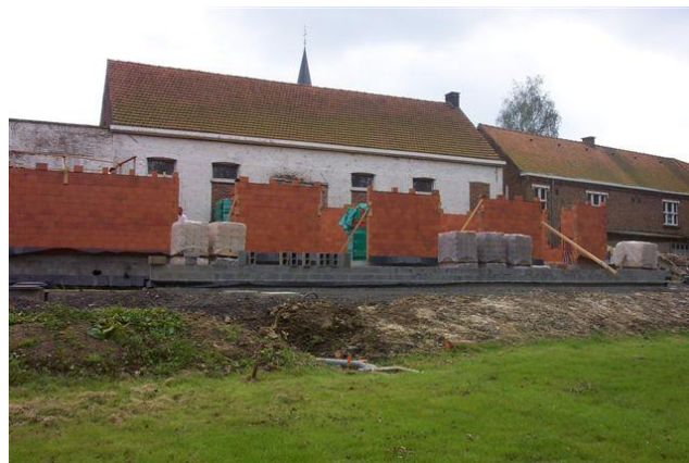
Zicht van de benedenkant
